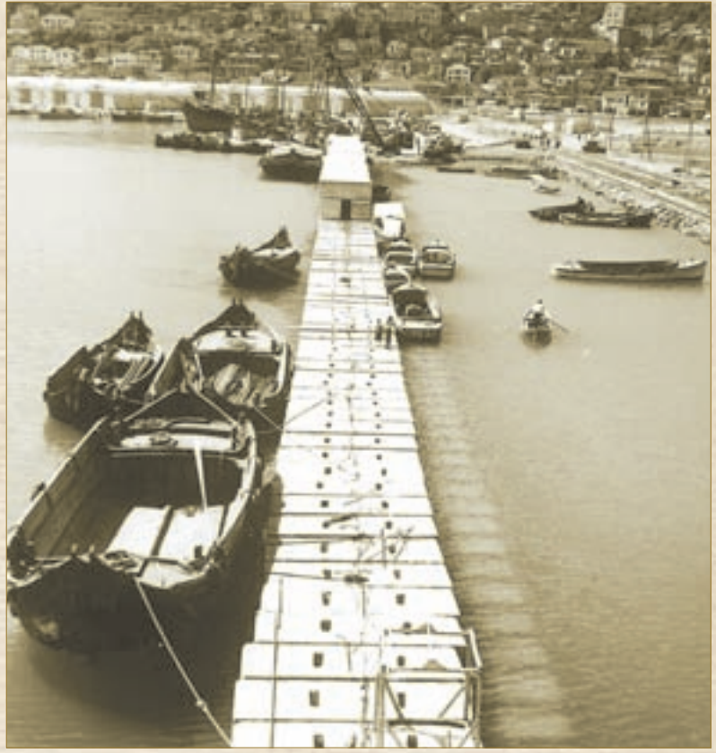
Trabzon limanı inşaatı, 1950'ler... Atilla Alp Bölükbaşı Arşivi
