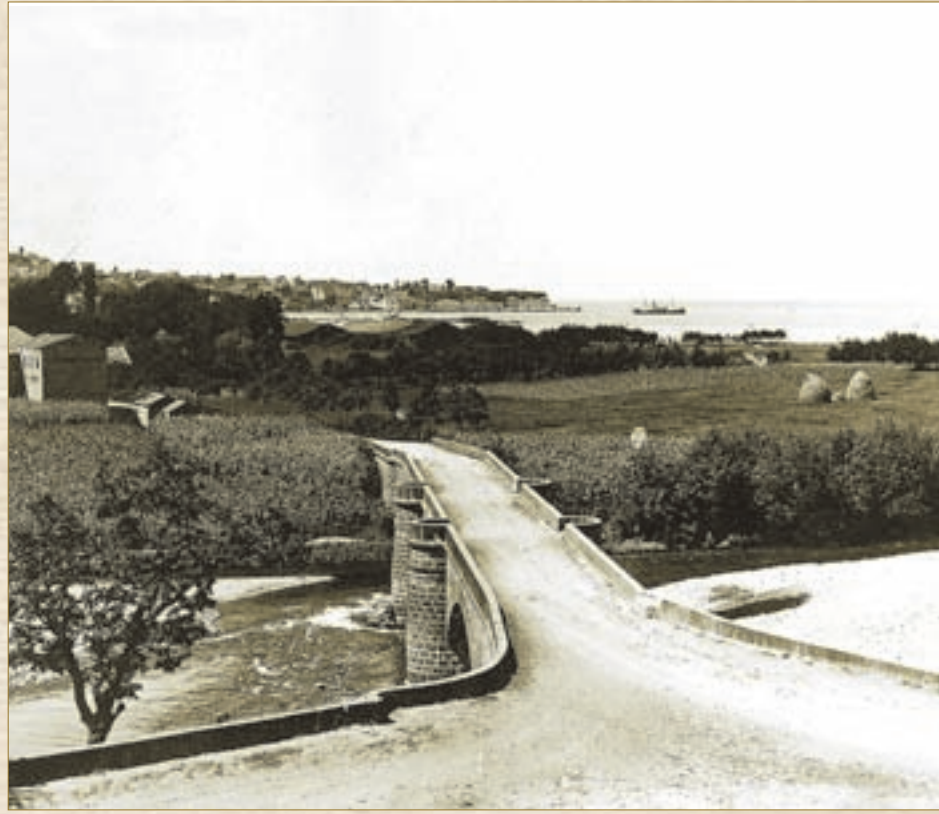
Nemlizadelerin yaptırduğu Değirmendere Köprüsü, 19. yüzyıl sonları...
