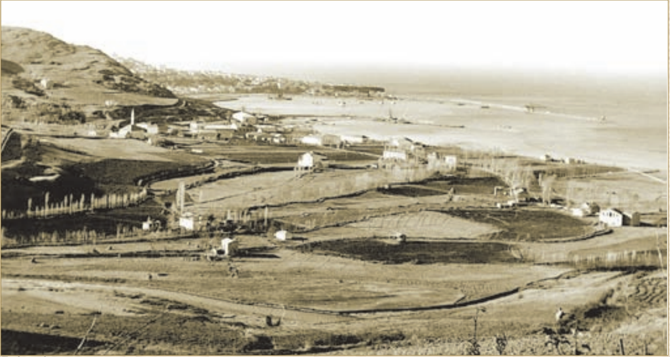
Trabzon limanı inşaatı, 1950'ler... Atilla Alp Bölükbaşı arşivi
